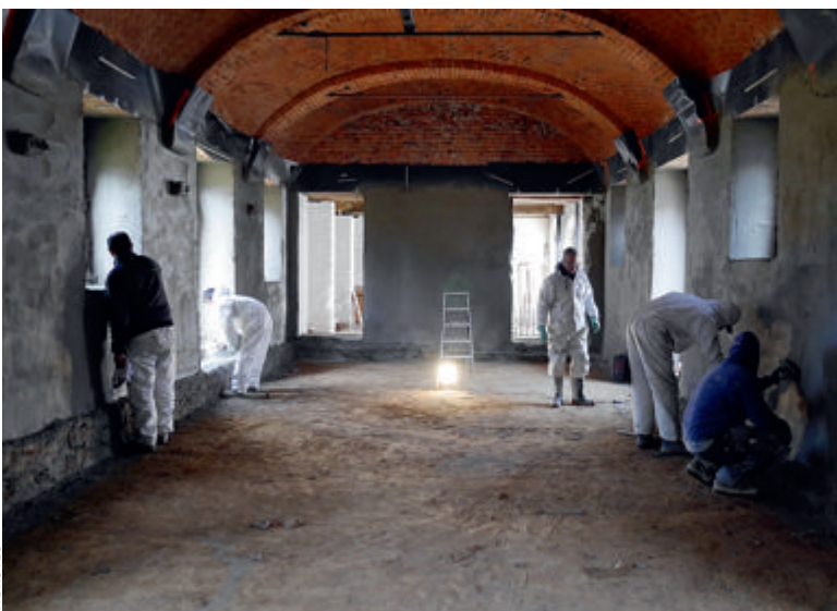
Pour réaliser une barrière anti-salpêtre, un enduit spécifique est appliqué sur les murs.
