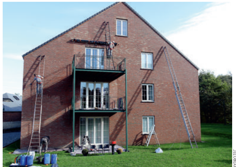
L'hydrofugation est l'application d'un produit imperméabilisant sur la façade du bien.
