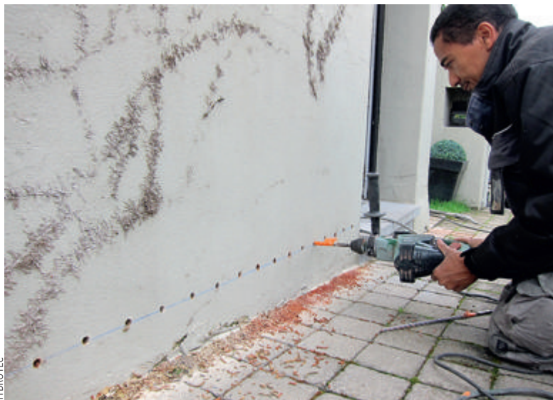
En cas d'humidité ascensionnelle, un produit hydrophobe est injecté dans les murs.
