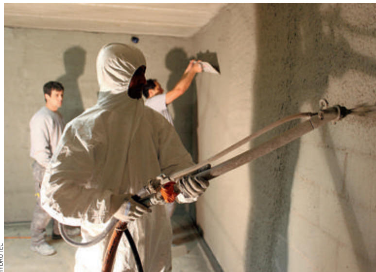
Un enduit hydrofuge est projeté à la lance pour assécher les caves humides.
